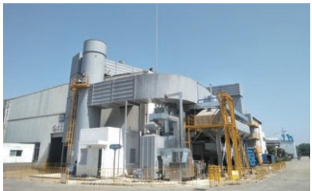
日立建机（中国）的VOC气体净化，脱臭装置设备
