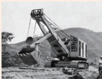
战后的混乱终于平复，河川，道路等基础设施完善事业要求具备经济性并缩短工期，因此，在1949年开发了机械式挖掘机“U05”。1950年进行了系列机型“U06”的量产，并投放日本国内市场。（照片所示为“U05”。）
