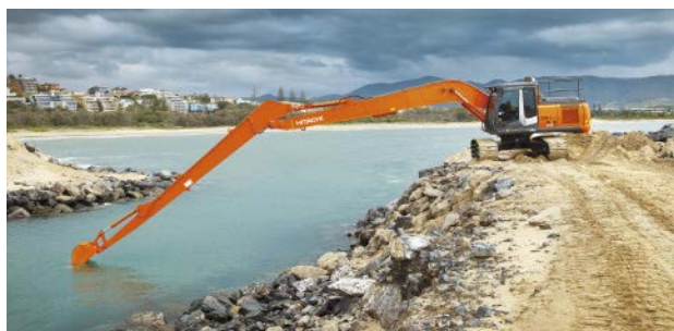
在河流疏浚工程可以有效地使用重视达到规格的机械。照片所示为在澳大利亚运营的「ZX240LC」（前端工作装置18m）。
