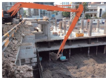
从地面上挖掘地下砂土的施工。照片所示为在印度尼西亚运营的「ZX210 LC-5G」（前端工作装置18m）。
