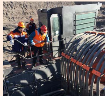
在蒙古施工现场检查更换配件的服务人员
