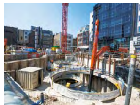
在伦敦的地铁隧道挖掘施工中运转的“ZX350LC伸缩式抓斗挖掘机”
