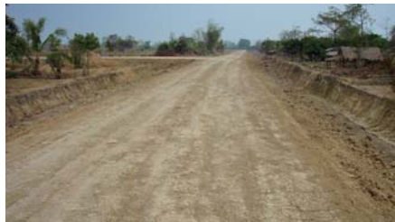
▲施工结束后斯拉邦村的道路
