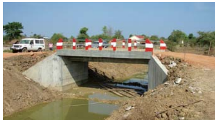
▲施工结束后斯拉邦村的桥梁
