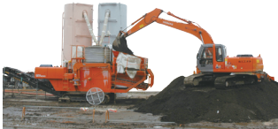
土壤净化现场
